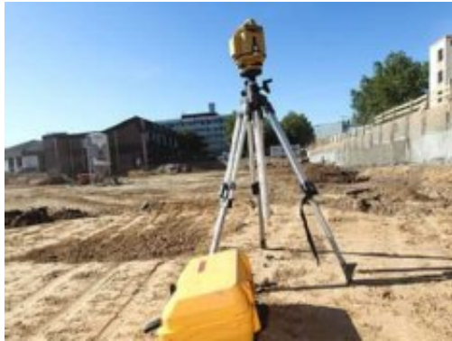
Vermessen wird derzeit das Gelände, auf dem das neue Ladenzentrum entsteht. Foto: Michael Schick
