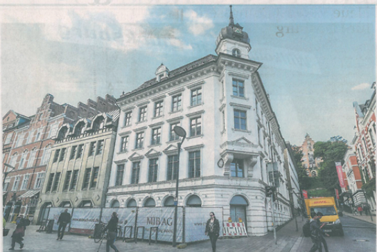
Die Umbauarbeiten im ehemaligen Nospa-Gebäude am Holm haben begonnen.
