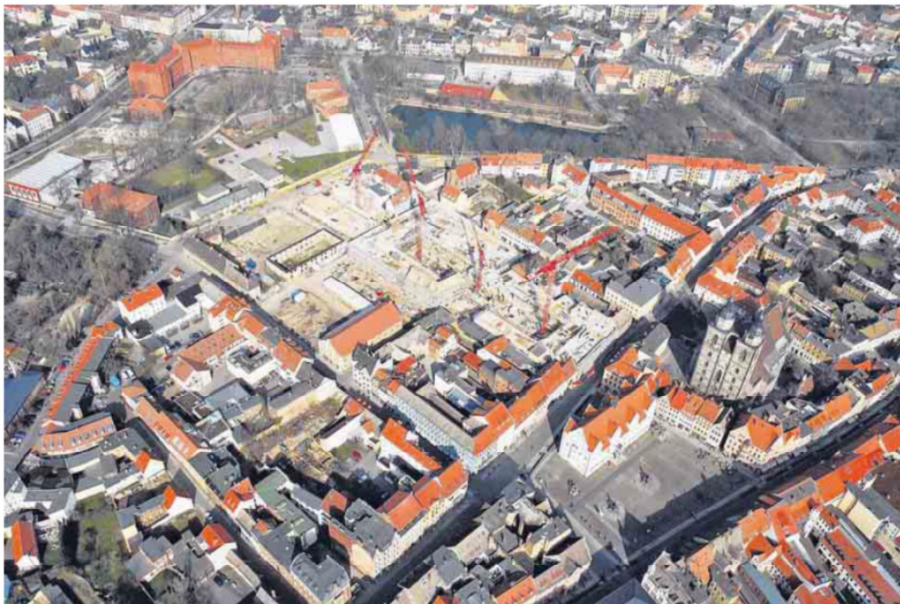
Der Arsenalplatz mit der Baustelle des Einkaufszentrums „Arsenal“. Wie man sieht, wird bereits der Dachstuhl aufgesetzt.
