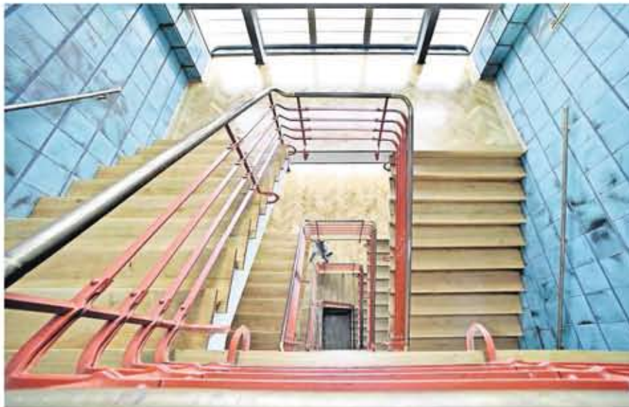
Das maritim gestaltete Treppenhaus ist längst wieder eine Augenweide. Bisher wurden aber nur diese „Modellachse“ sowie die Festsäle im vierten Stock saniert. Foto: Volkmar Heinz
