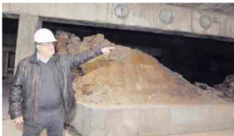
Bauleiter Olaf Zocher in der Tiefgarage vor dem umbauten Hans-Luft-Keller
