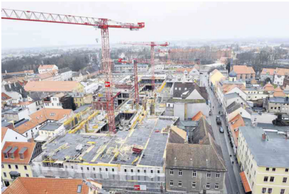
Die Großbaustelle, vom Turm der Stadtkirche aus gesehen. Dort ist auch eine Webcam installiert. Ihre Bilder gibt es auf der Wittenberg-Homepage.
